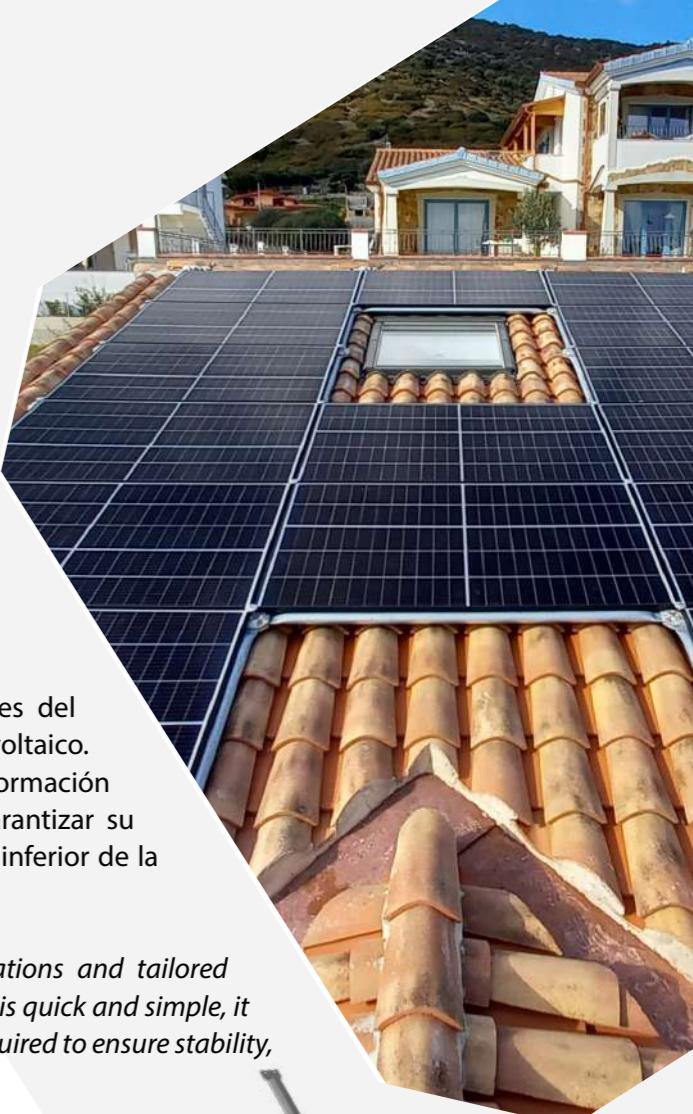
Cada estructura Omniablok se diseña según las especificaciones del tejado y se fabrica a medida según las dimensiones del panel fotovoltaico. El montaje del sistema es rápido y sencillo, no requiere ninguna formación específica del operador; las pocas fijaciones necesarias para garantizar su estabilidad se limitan al punto de cumbre y a la parte terminal inferior de la estructura.
