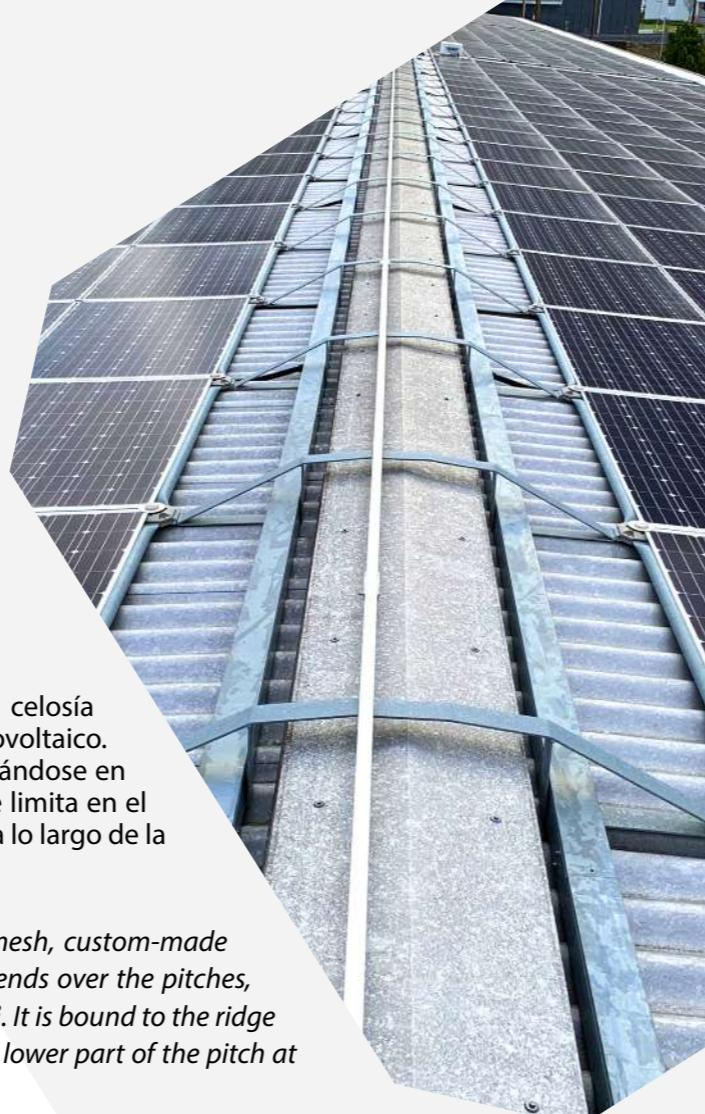
El sistema de cubierta inclinada Omniablok es una malla de celosía totalmente conectada, hecha a medida del tamaño del panel fotovoltaico. La estructura Omniablok se extiende sobre las pendientes, apoyándose en la cubierta del tejado, con un peso aproximado de  $6,5 \text{ kg/m}^2$ . Se limita en el punto máximo, donde el riesgo de infiltración se reduce a cero y a lo largo de la parte baja del acuífero en muy pocos puntos.
