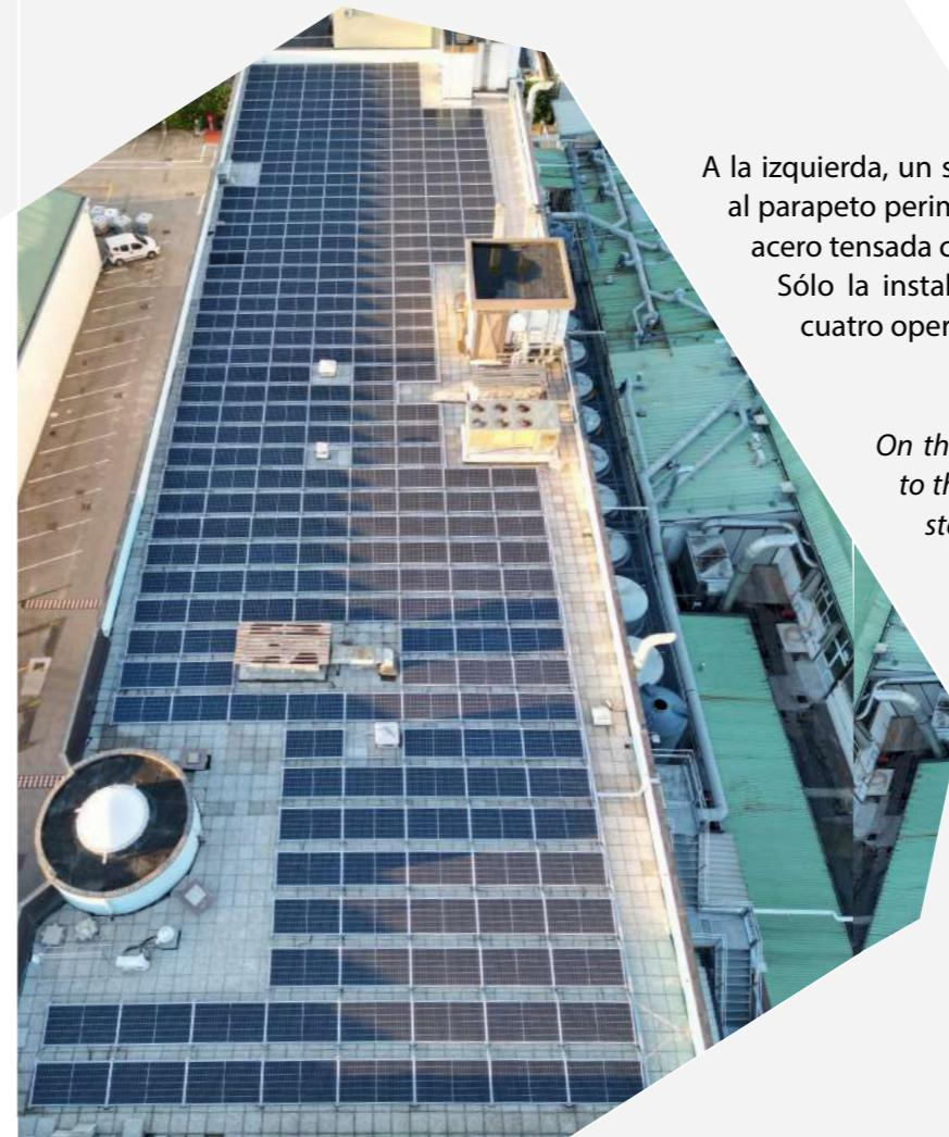
A la izquierda, un sistema fotovoltaico formado por 305 paneles, fijados al parapeto perimetral en tan solo 11 puntos, mediante una cadena de acero tensada con tensores de doble horquilla.
